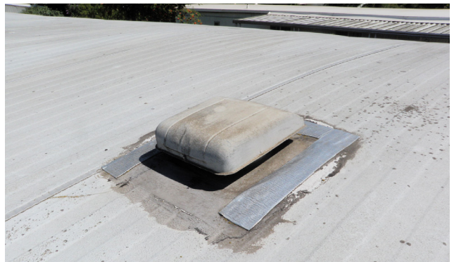
VENTILACIÓN DEL ÁTICO
