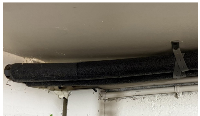
INSULACIÓN DE TUBERÍAS
